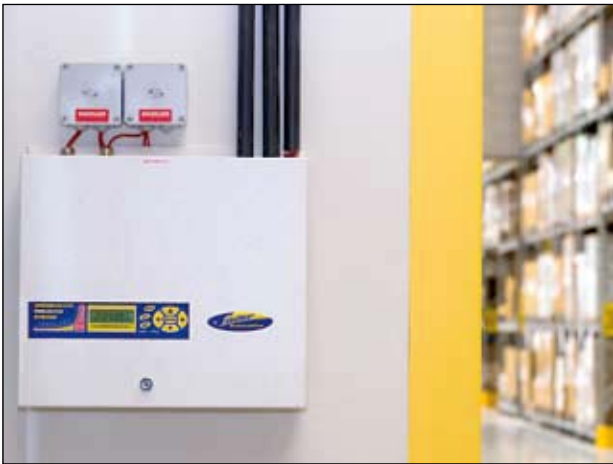
Samplingsenheterna sitter lätt åtkomliga vilket underlättar vid service.
