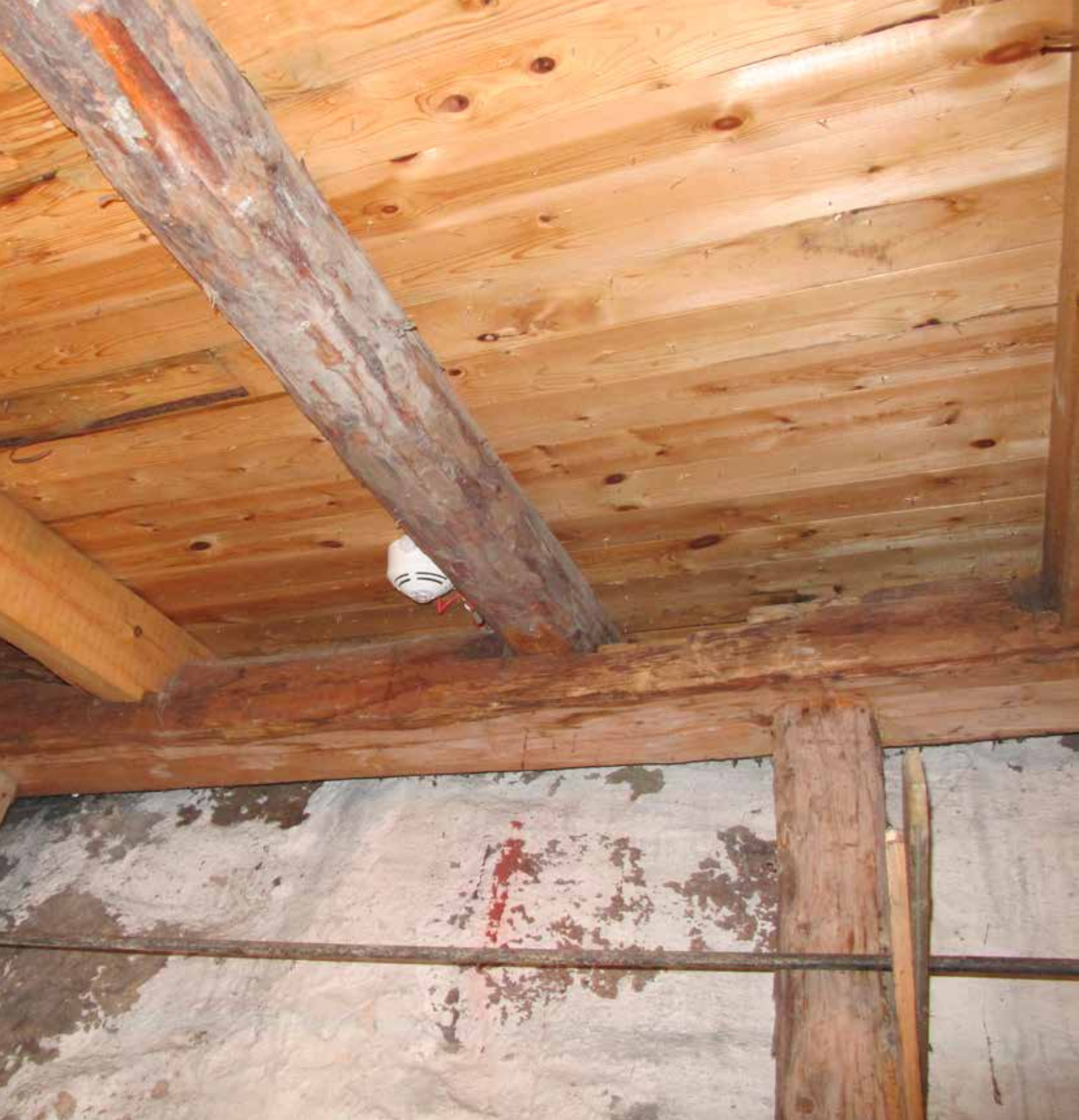
Fig.14. En detektor har även satts upp i benkammaren. Fotot är taget efter arbetena genomfördes. LP_2015_00021, foto: H. Bellberg.
