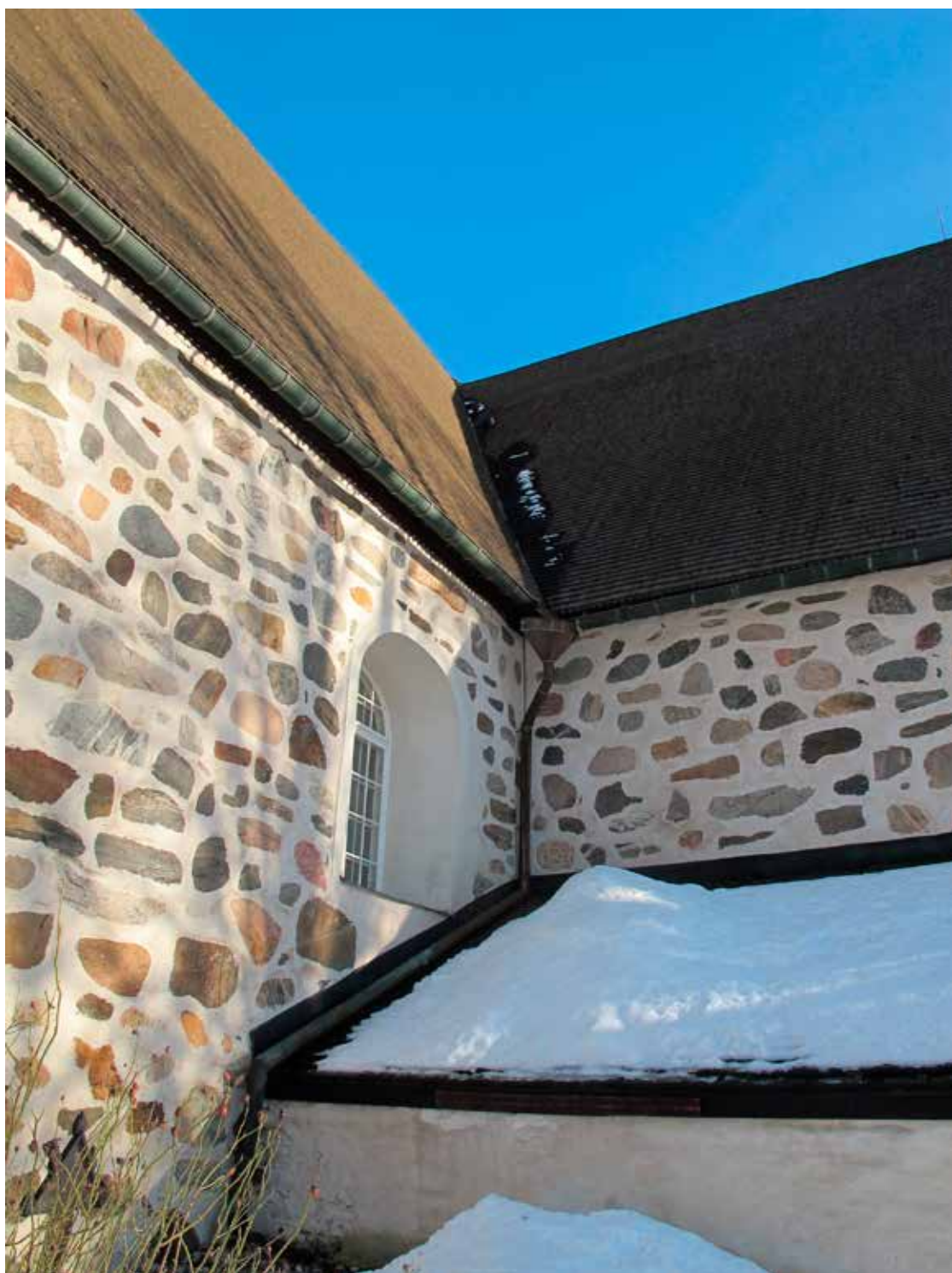
Fig.15. Den nya kabeldragningen till benkamardetektorn är smäckert placerad bakom stupröret ovanför benkammarens tak. LP_2015_00022, foto: H. Bellberg.
