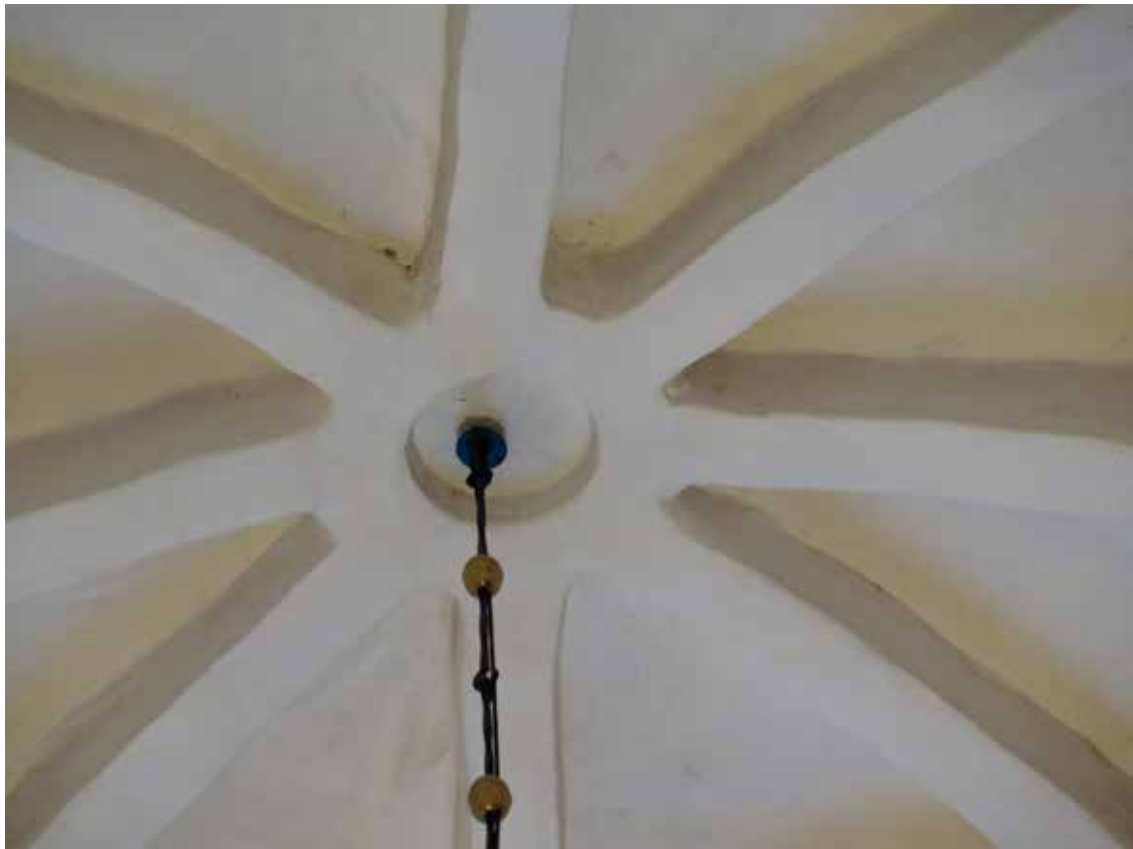
Fig.2. Befintligt hål i takvalv för ljuskronans upphängning. Genom detta placeras en ny detektor. Fotot är taget före åtgärden genomfördes. LP_2015_00003, foto: K. Myhrberg.
