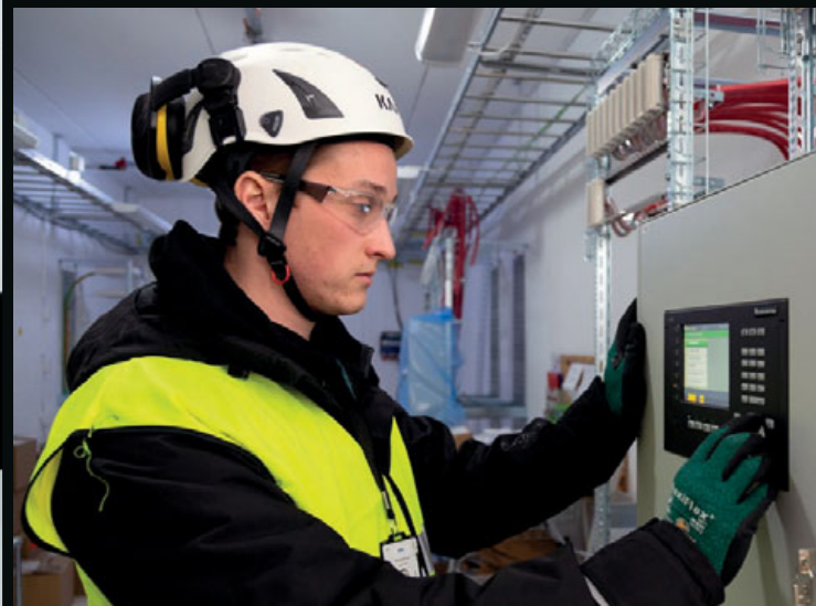
William Eriksson, SEAL Scandinavia, vid en av brandlarmcentralerna.
