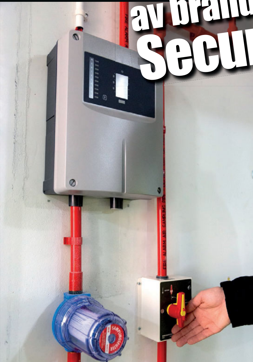
Samplingscentral. Till höger syns snabbanslutningen för tryckluft för rengöring av rörsystemet.
